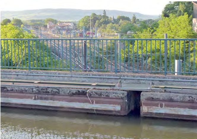
鉄道と運河橋 運河橋の下に線路が見える。
