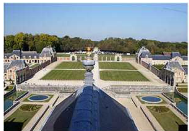
宮殿北側 濠が城館を囲んでいる。付属の建物も左右対称。正門も軸線上に。
