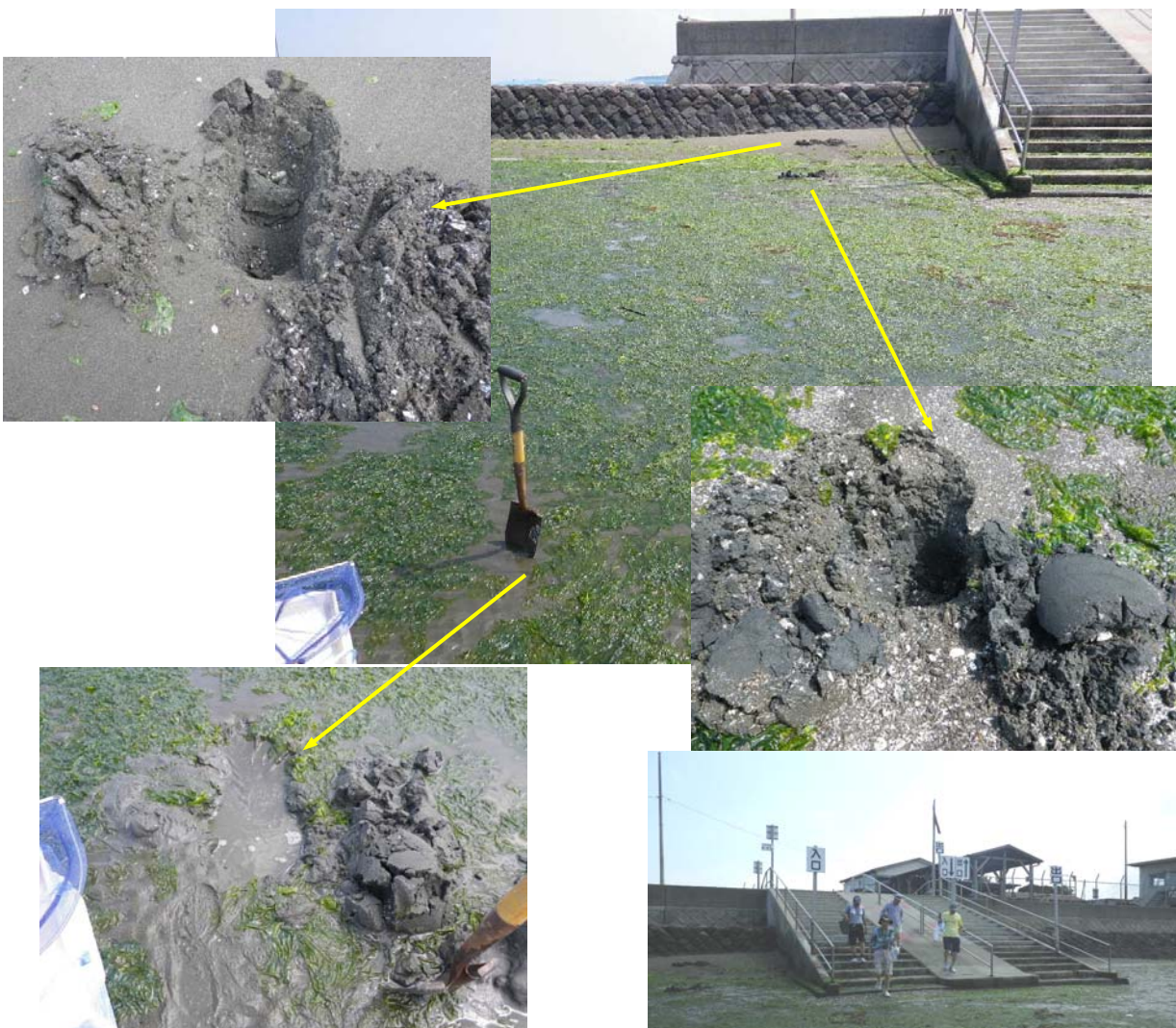
写真3 岸寄り、護岸付近の状況
